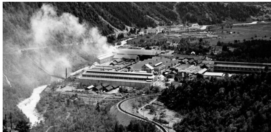
L'usine de Péchiney de Chedde en 1960 environ (cf. Article « Usine de Chedde : une épopée ouvrière mémorable » du journal Le Messenger)
