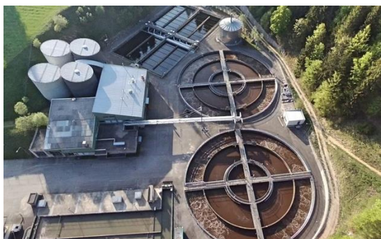
Figure 1 : Vue du dessus de la station d'épuration de La Chaux-de-Fonds
