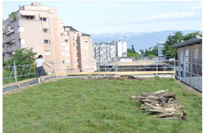
Toit végétalisé des Voies Couvertes © 1001 Sites Nature En Ville
