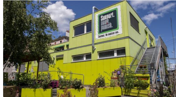
Quai 9, local d'injection près de la gare Cornavin
