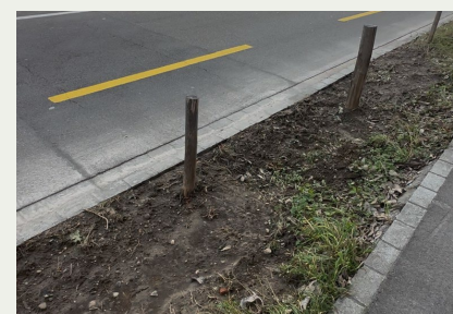
Abb. 3: unscheinbare Rigole mit einem Oberboden am Strassenrand der Allmendstrasse, Zürich
