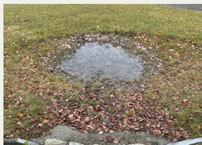
Abb. 1: natürliche, muldenartige Rigole auf dem Friedhof Manegg zur Wasserversickerung
